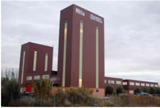
Edificio del ITA.
